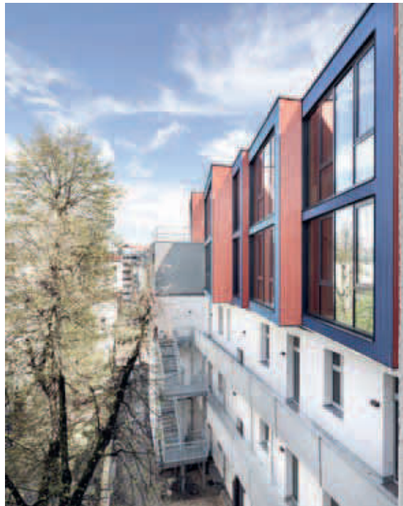
Eine Aufstockung aus Holz verbindet Vorderhaus und Seitenflügel eines Altbaus harmonisch mit dem Deutschen Chorzentrum in Berlin.
