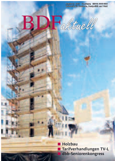
Einsatz von Holzelementen auf der Baustelle des Wohn- und Geschäftshauses Z8 in Leipzig-Lindenau
