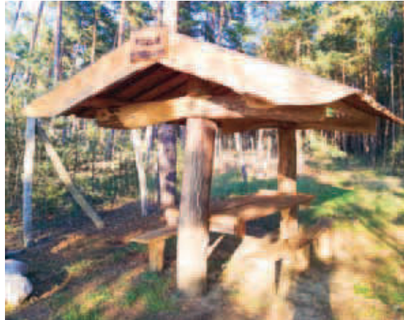
Der Unterstand ist natürlich selbst gebaut: selber gefällt, aufgesägt zu Bohlen und dann weiter bearbeitet – zu 100 % selbst gemacht!
