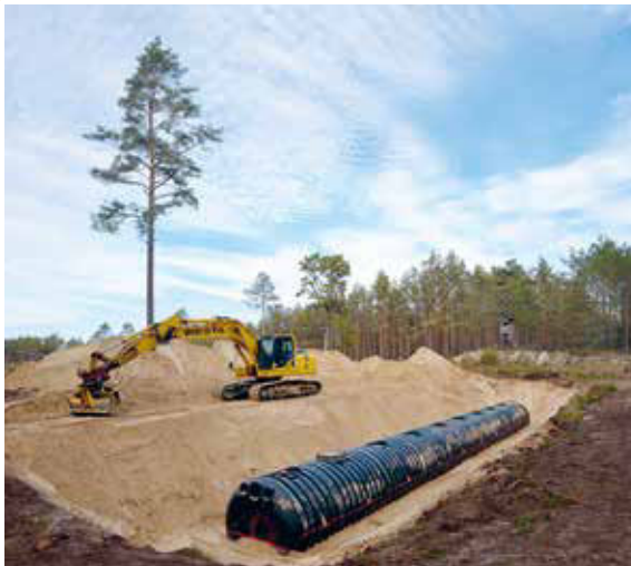
Errichtung einer Löschwasserzisterne am Waldbrandriegel im Forstamt Kaliß
